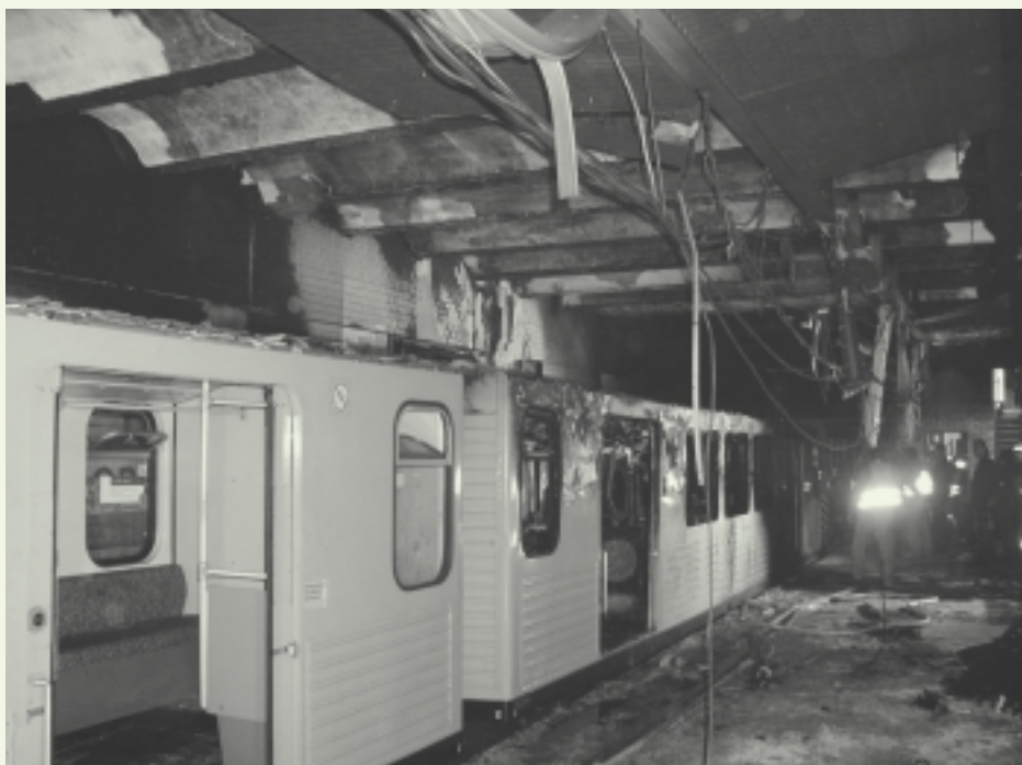
Berlin – BVG : station Deutsche Oper après le feu (2000)
