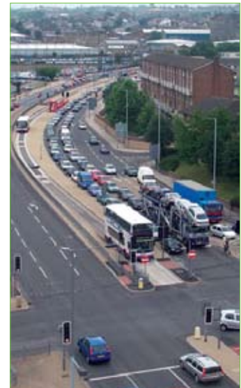
Voie de bus réservé, Manchester, Royaume-Uni.
